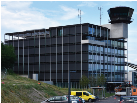
Le nouveau centre des opérations, avec sa vigie en surplomb.
